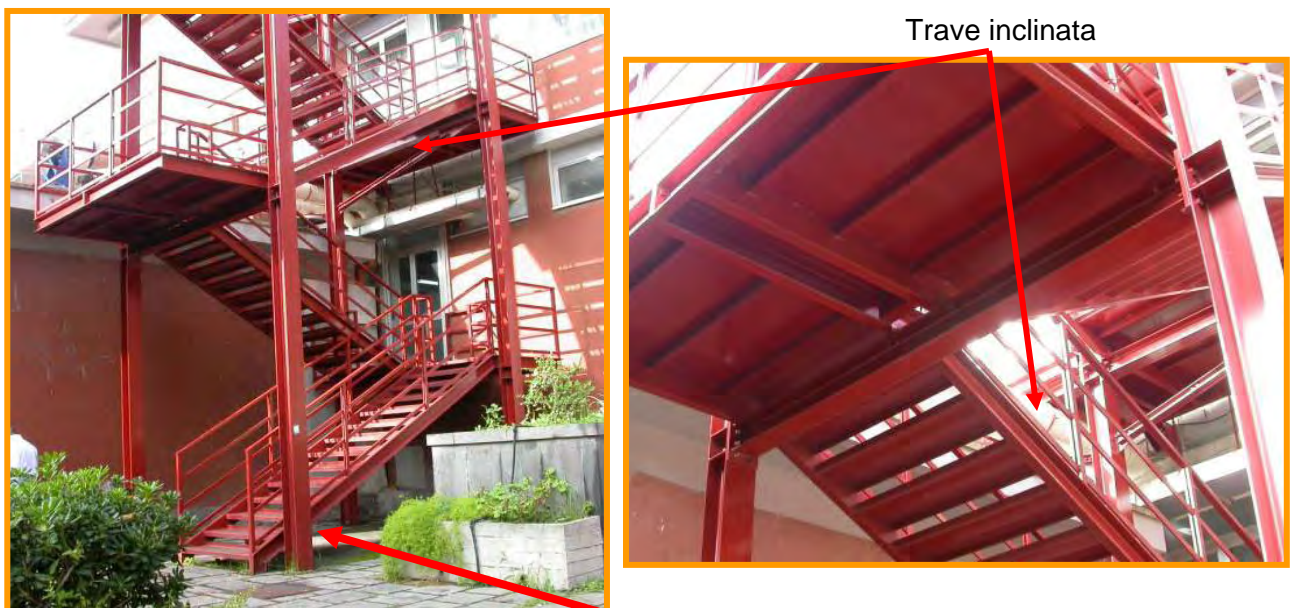
Telaio portante con 4 colonne
