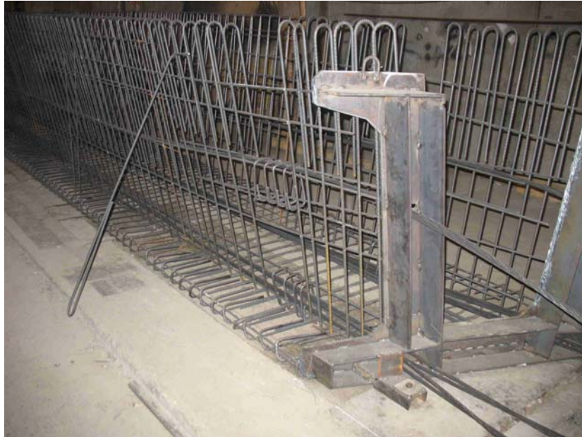
Figura 6.3 - L'armatura lenta di un tegolo in c.a.p.
