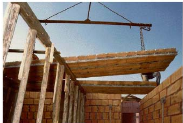
Figura 10.14 – Varo di solaio a pannelli prefabbricati
