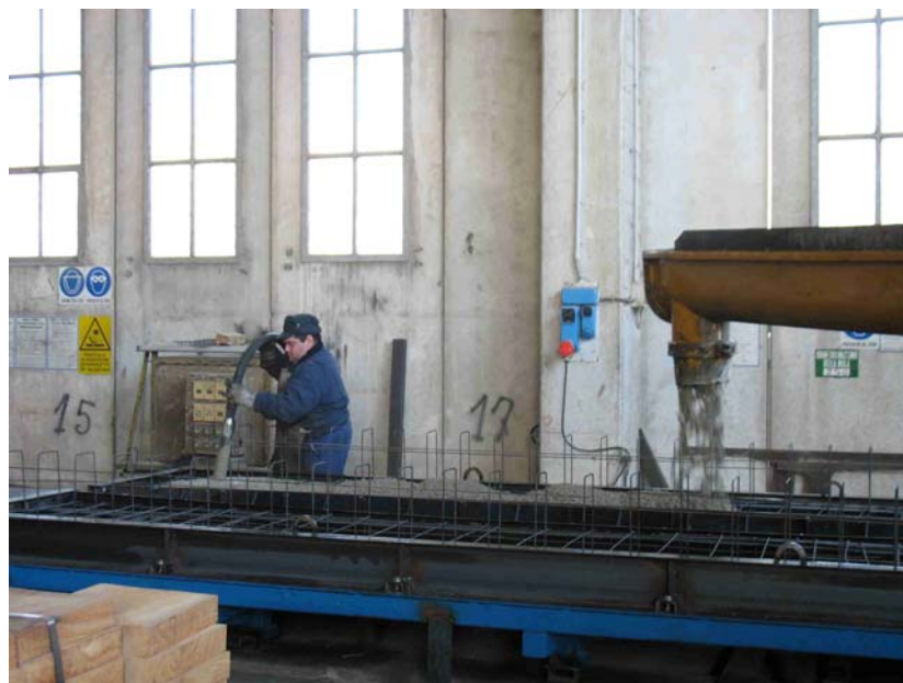
Figura 6.2 - La fase del getto e della vibratura in uno stabilimento
