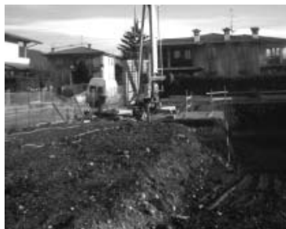
▲ Attenzione alla consistenza della parete dello scavo
