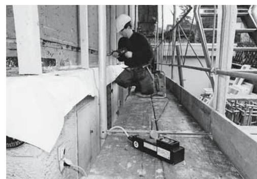
Figura 8: in mancanza di un distributore di corrente per cantieri allacciare l'interruttore FI (salvavita) portatile.
