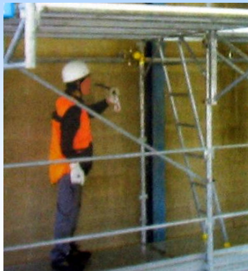
SCAVALLARE TUTTI GLI SPINOTTI DEI MONTANTI DEL LIVELLO SUPERIORE
