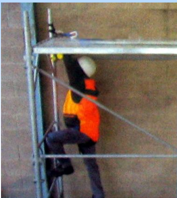
PREDISPORRE L'ANCORAGGIO AD UNA ESTREMITA' DEL PONTEGGIO
