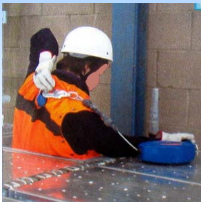
ASSICURARE L'ARROTOLATORE ALL'IMBRACATURA DI SICUREZZA
