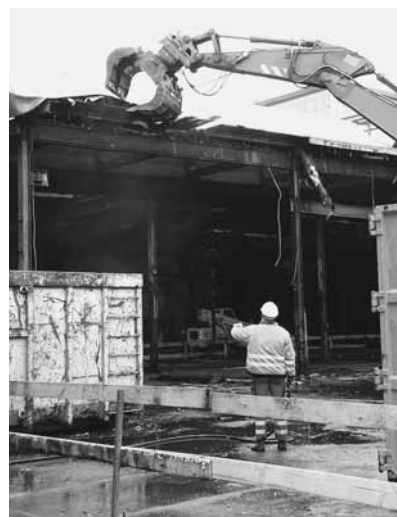
Fig. 3: la zona di pericolo è stata messa in sicurezza mediante sbarramenti e posti di sorveglianza per evitare l'accesso alle persone non autorizzate.
