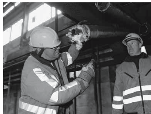
Fig. 6: gli operai devono segnalare i materiali critici inaspettati alla persona competente sul posto.
