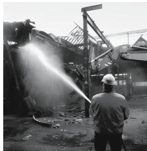
Fig. 5: la formazione di polvere deve essere contenuta con adeguate misure, ad es. nebulizzazione d'acqua sull'apparecchio demolitore, irrorazione con acqua.
