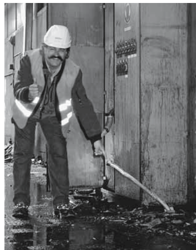
Fig. 1: i lavori di demolizione selettiva possono iniziare soltanto quando è stata confermata la messa fuori servizio di tutte le linee industriali.
