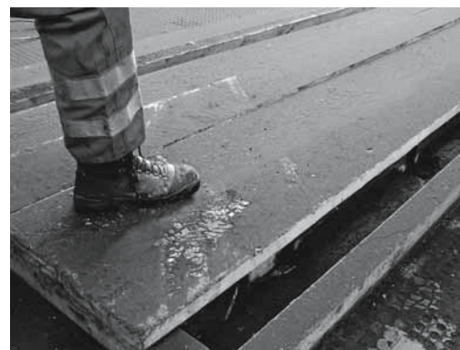
Fig. 4: attenzione a coperture, griglie, contropavimenti ecc.: pericolo di rottura.
