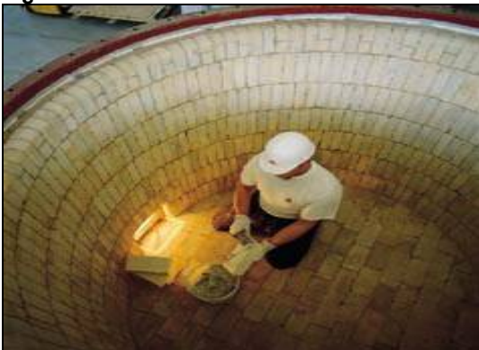
Fig.1 – Rifacimento refrattario
