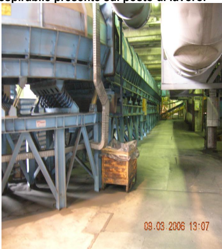
fig. 1 tunnel di sterratura/trasporto dei getti dopo distaffatura.
