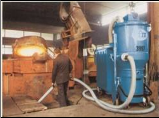
Fig. 2 Impianto aspirapolvere carrellato
