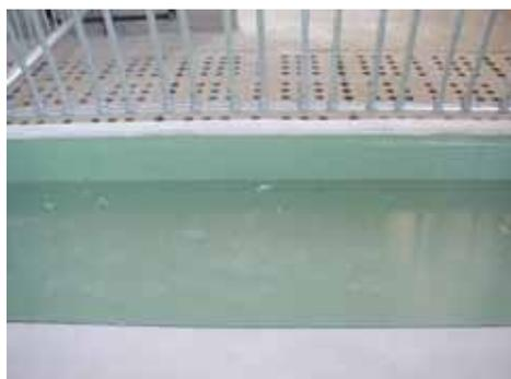
Figura 27 – Mangiatoia rivestita in resina epossidica.
