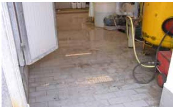
Figura 1 – Insufficiente drenaggio causa pericolosi ristagni d’acqua.
