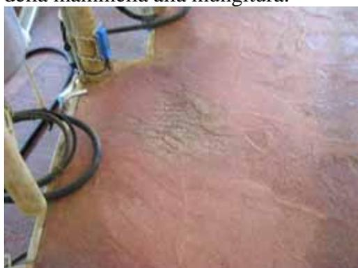
**Figura 21 – Pavimento in battuto di cemento antiscivolo, parzialmente corrosso in corrispondenza dell'attacco del gruppo di mungitura.**
