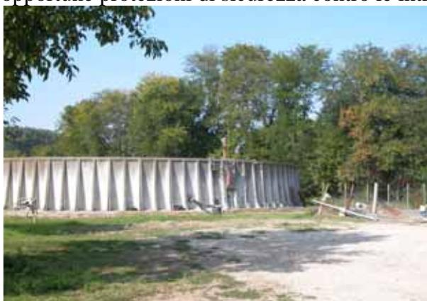
Figura 14 – Vasca stoccaggio liquame, per consentire l'accesso per ispezione e manutenzione attrezzature, la vasca va dotata di idonea scala e piattaforma.
