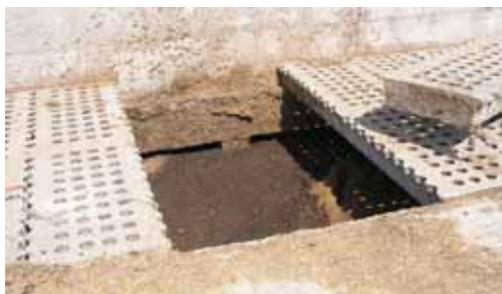
**Figura 2 – Settore di pavimento fessurato spostato per consentire il pompaggio del liquame.**
