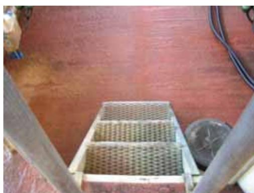
**Figura 22 – Scala di accesso alla buca di mungitura senza protezioni laterali.**
