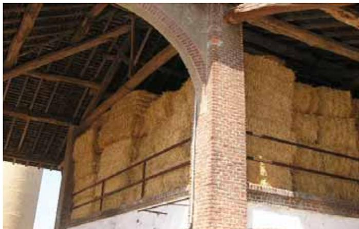
**Figura 1 – Nei fienili i rischi più frequenti sono dovuti a sovraccarico del solaio e ribaltamento delle balle.**
