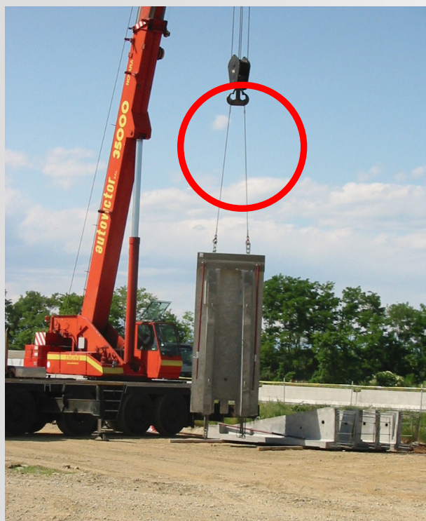
Sollevamento muro tipo "paver"
