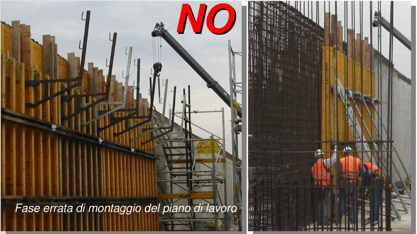
*Fase errata di montaggio del piano di lavoro*
