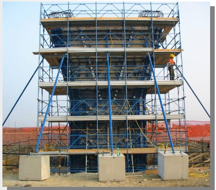
Quando, per necessità realizzative, il piano di lavoro non è aderente rispetto all'opera da realizzare, il ponteggio dovrà essere provvisto di parapetto anche nel lato interno o potrà essere allargato l'impalcato con tratti a sbalzo.
