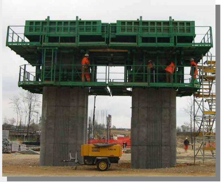
*Le casserature metalliche riutilizzabili vanno realizzate secondo lo specifico piano di montaggio predisposto dal costruttore.*
