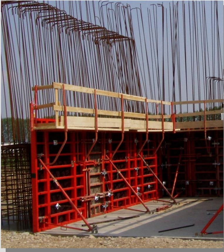
*La realizzazione del ponteggio deve seguire necessariamente lo sviluppo verticale dell'opera in corso di realizzazione.*
