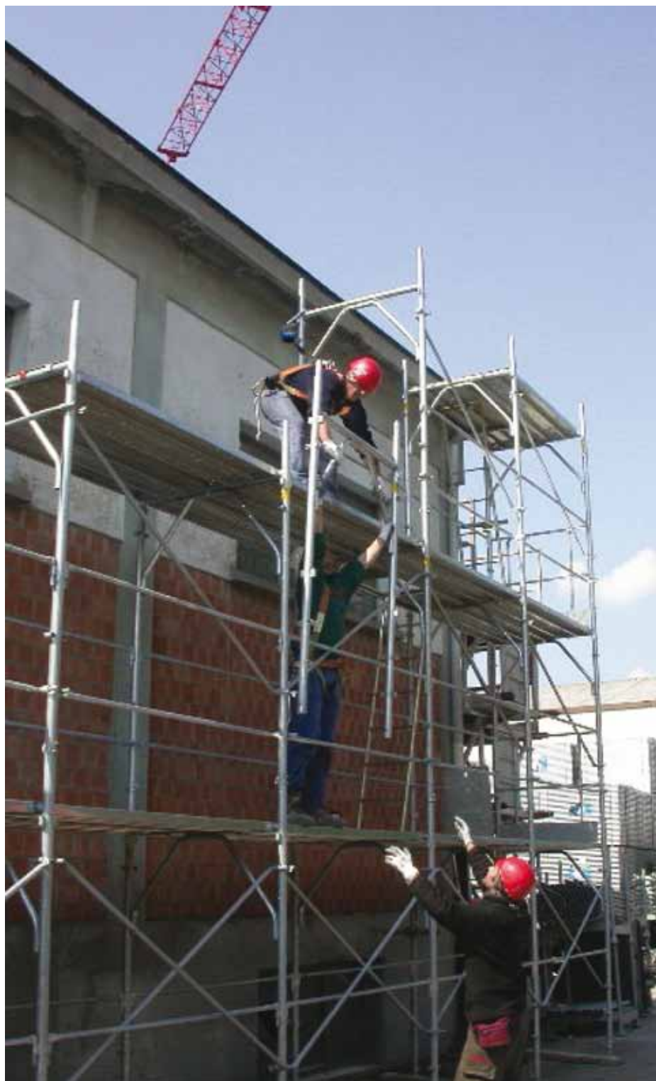
Foto 5. Montaggio ponteggio a telai con utilizzo DPI arresto Caduta.
