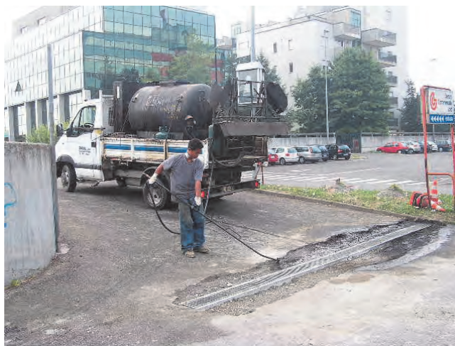
Figura 24 - Applicazione emulsione bituminosa manuale
