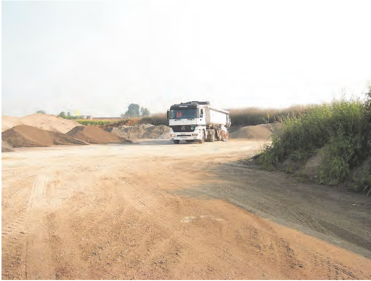
Figura 13 - Arrivo inerti allo stabilimento di produzione
