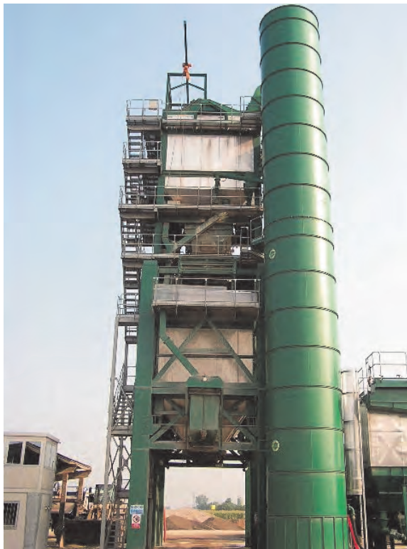
Figura 21 - Torre di miscelazione
