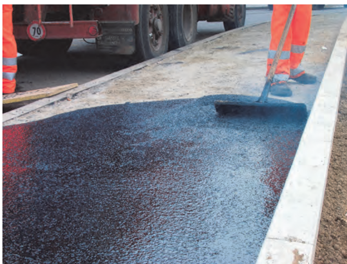
Figura 34 - Stesa di asfalto colato su marciapiede
