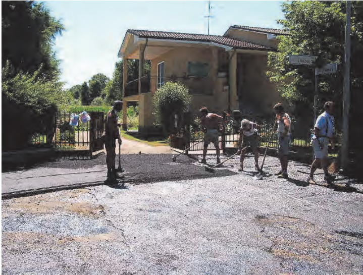
Figura 26 - Stesa asfalto manuale
