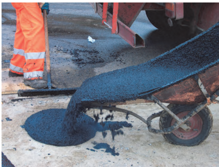
Figura 33 - Stesa di asfalto colato su marciapiede
