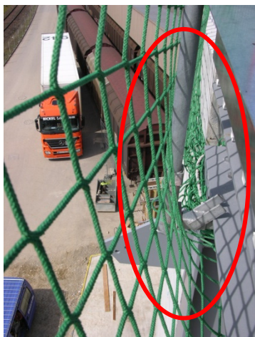
3 La rete di sicurezza verticale deve essere fissata in modo tale che sotto carico non si formino delle aperture superiori a 30 cm.
