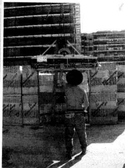
6-aprire la gabbia e scaricare il carico
