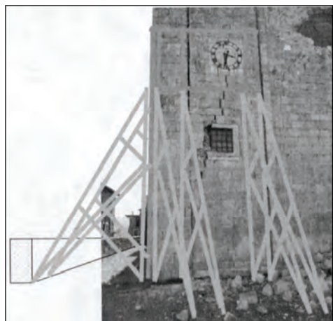
Puntellamento della porzione di angolo sinistro della facciata (Archivio NCP).
