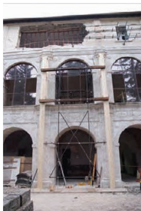
Elementi di distribuzione verticale sulle facciate in legno lamellare (Archivio NCP).
