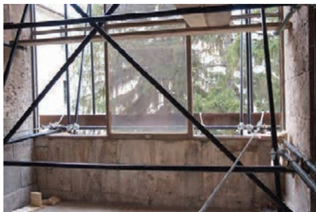
Sostegno dei traversi di ancoraggio con sistema tubo-giunto (Archivio NCP).
