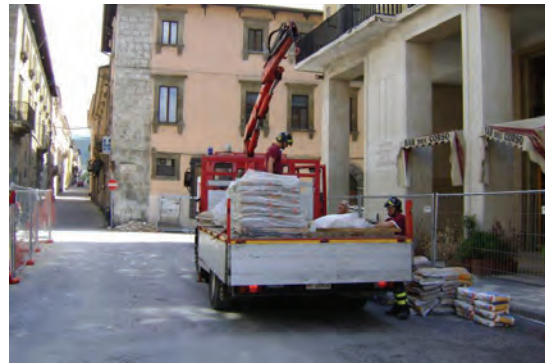
Allestimento dell'area di deposito dei materiali (Archivio NCP).
