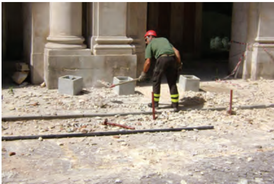
Pulizia del cantiere dalle macerie (Archivio NCP).
