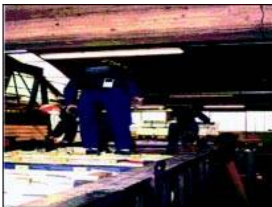
Figura 1: Montaggio del rivestimento in FCR sul tetto di un forno per ceramiche
