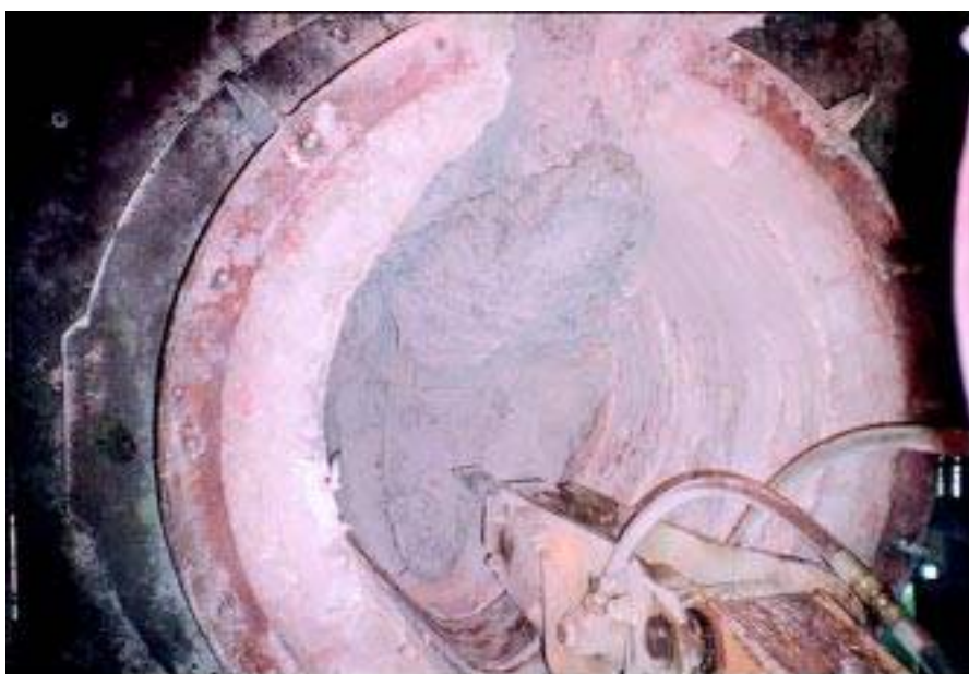
Figure 11 e 12: Demolizione di un forno fusorio in fonderia. La fibra è confinata tra la pigiata refrattaria e il cemento refrattario
