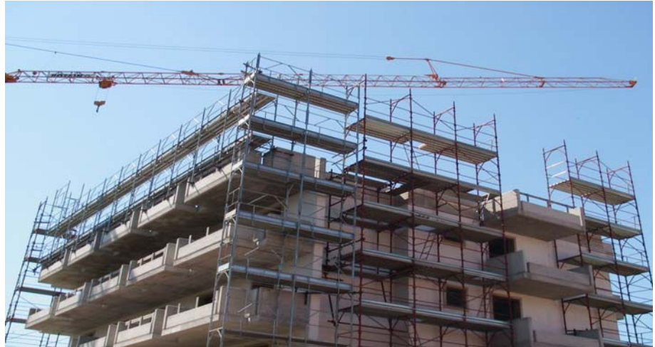
Fig. 7 Ponteggio avente diversa profondità in funzione della pianta dell'edificio
