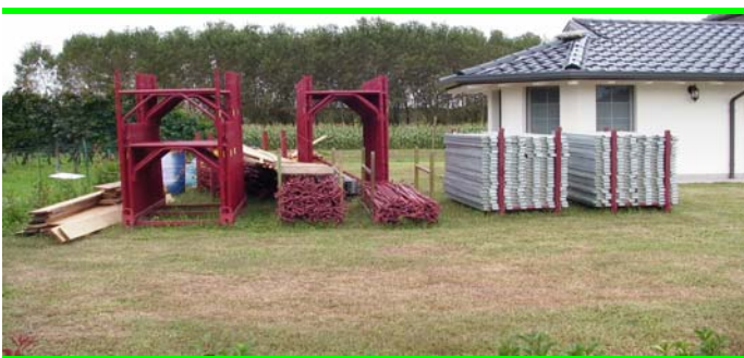
Fig.9 Deposito ponteggio a telai prefabbricati
