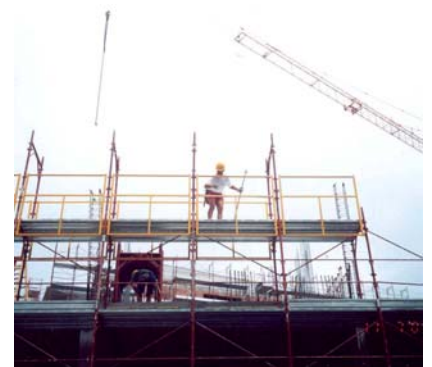
posa correnti parapetto
