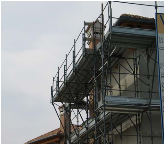
Figura 11 – Sbalzo per lavori su lina
