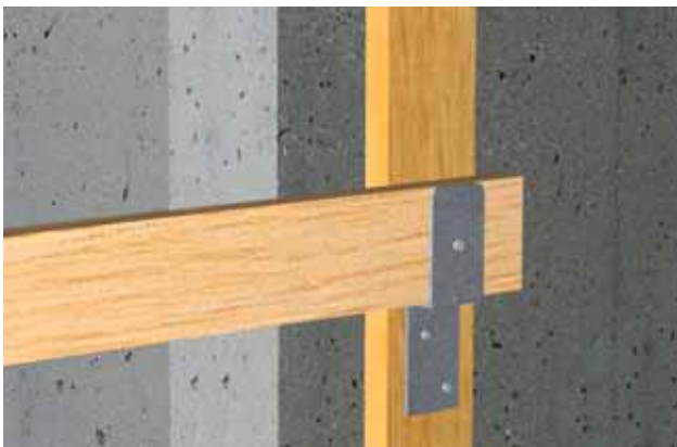
18 Supporto semplice. L'asse della protezione laterale è tenuta ferma da un chiodo.
