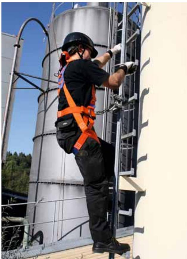
**Figura 7** protezione anticaduta con scala e binario di guida su un camino di fabbrica.
