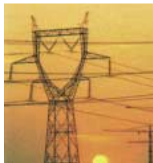
Fig. 47: I tralicci dell'alta tensione sono quotidianamente causa di interferenze con le apparecchiature e con il nostro corpo.
